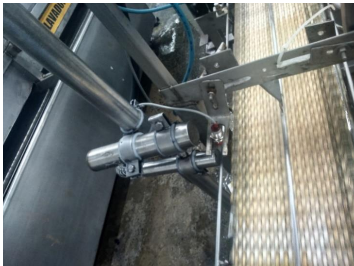
Figura 3-10: Montaje de sensor inductivo.
