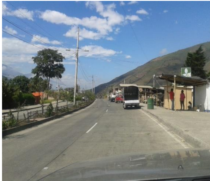
Ilustración 7: Avenida Velasco Ibarra del cantón Pallatanga Fuente: Investigación de campo
