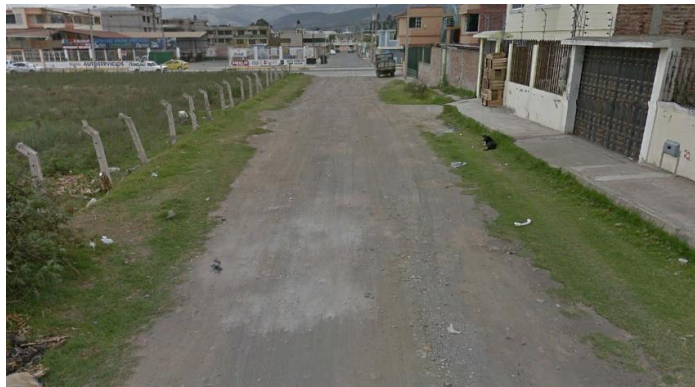
Fotografía 2-2. Calle lastrada del barrio San Francisco de Pisín (excluido)
