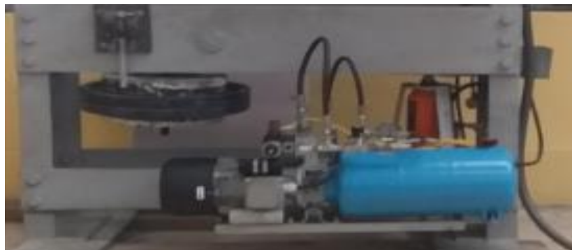
Figura 8-5: Montaje la central hidráulica
