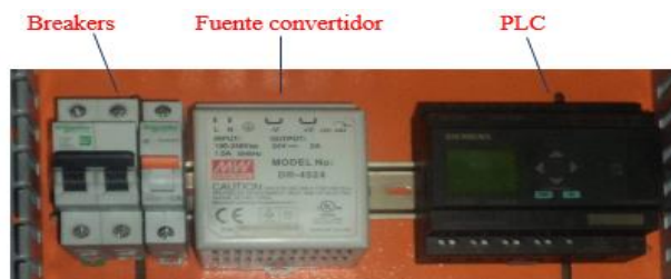
Figura 13-4: Armado Breakers, Fuente y PLC
