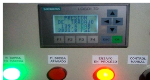
Figura 2-5: Pruebas preliminares del tablero de control
