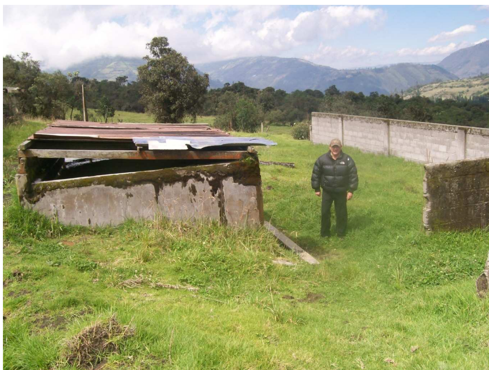
Fotografía 5. Reservorio de agua.
