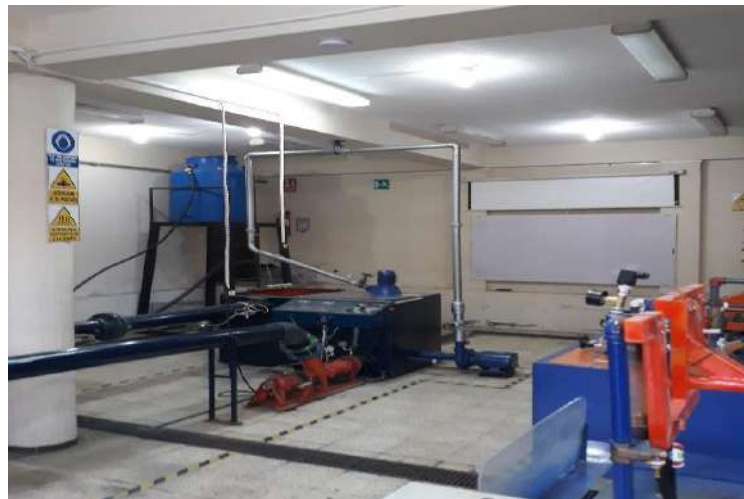
Figura 5-9: Detector de humo I – laboratorio de turbo maquinaria Realizado por: Jorge Encalada, 2018
