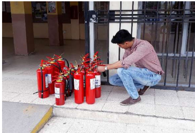
Figura 5-1: Recarga y adquisición de Extintores portátiles (PQS y CO2)
