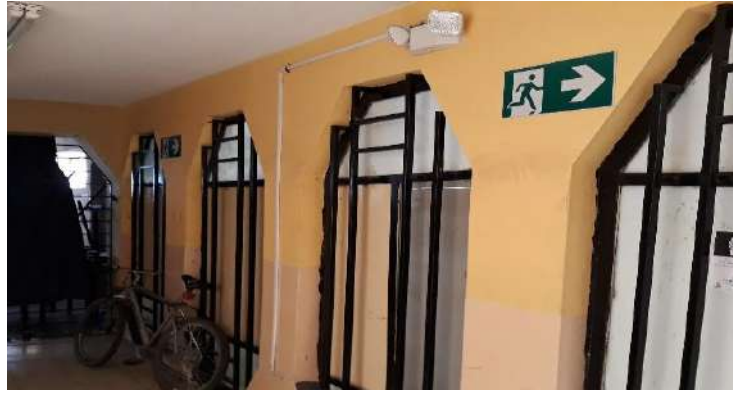
Figura 5-6: Instalación de luces de emergencia en la planta baja de la E.I.M Realizado por: Jorge Encalada, 2018
