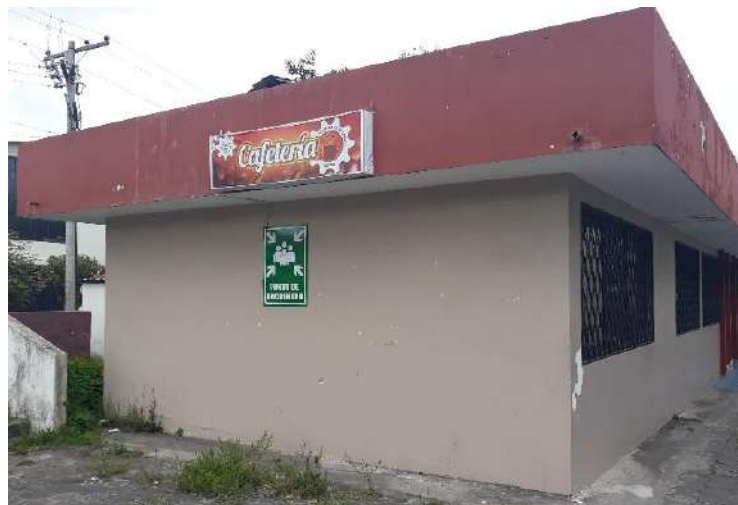
Figura 5-21: Punto de encuentro antiguo para la edificación de la E.I.M Realizado por: Jorge Encalada, 2018
