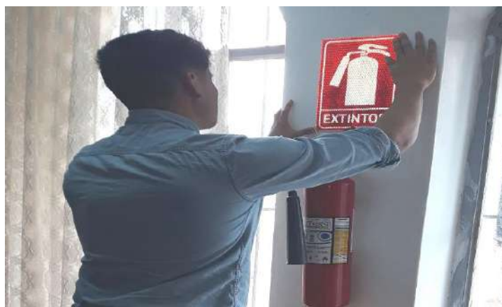
Figura 5-19: Señalética de protección contra incendios E.I.M planta alta Realizado por: Jorge Encalada, 2018
