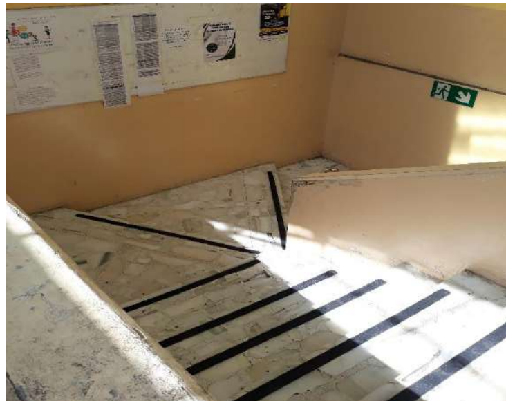
Figura 5-30: Colocación de cinta antideslizante en las gradas de la E.I.M Realizado por: Jorge Encalada, 2018
