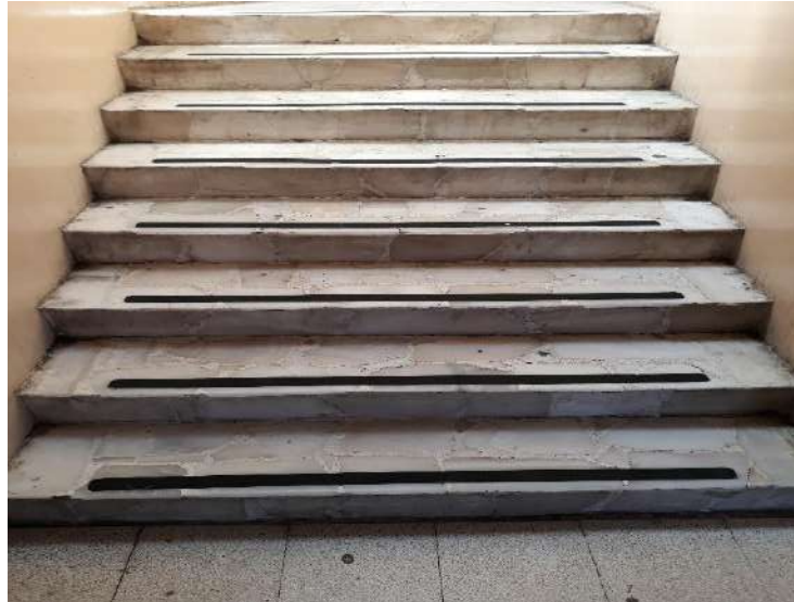
Figura 5-31: Colocación de cinta antideslizante en las gradas de la E.I.M Realizado por: Jorge Encalada, 2018
