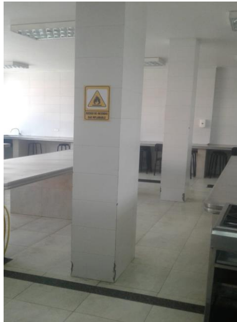
Figura 4-11: Señalética instalada de riesgo de incendio en el laboratorio N° 2.
