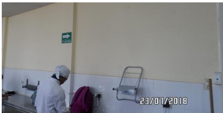
Figura 4-21: Señalética instalada de ruta de evacuación en el laboratorio N° 3.
