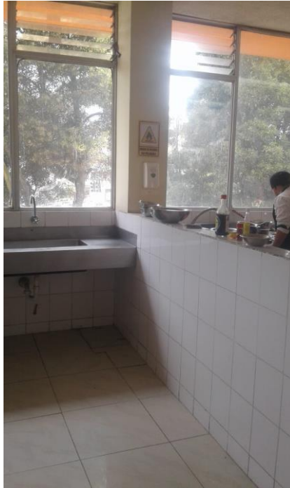
Figura 4-13: Señalética instalada de riesgo de incendio en el laboratorio de técnica dietética.
