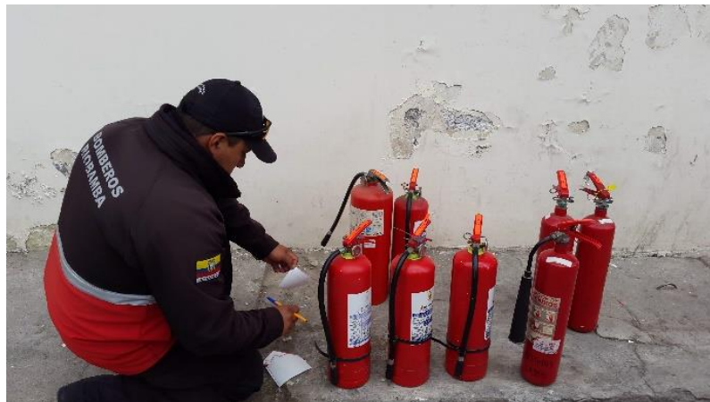
Figura 4-29: Inspección de extintores por el Cuerpo de Bomberos GAD Riobamba.
