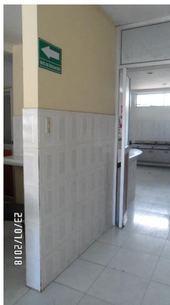
Figura 4-23: Señalética instalada de ruta de evacuación en el laboratorio N° 4.
