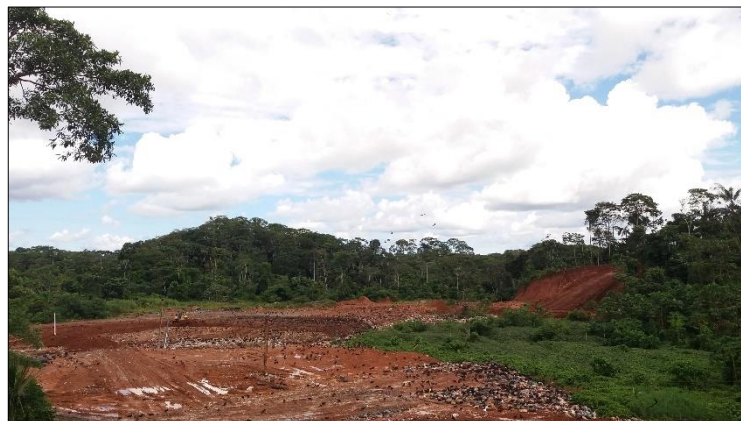
Fotografía 2-1: Estado actual del Botadero del Cantón Francisco de Orellana. Elaborado por: Génesis Montezuma, 2018
