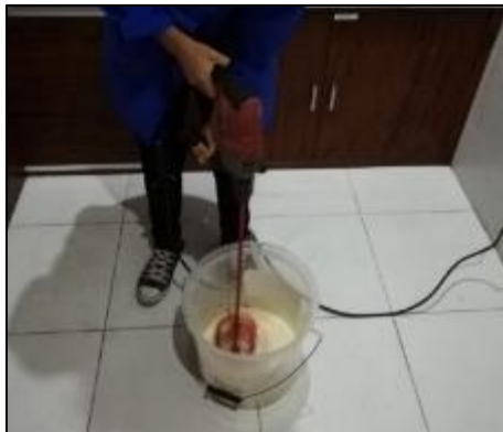
Fotografía 11-3: Preparación del adhesivo de la 3F.
