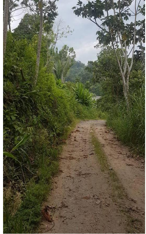
Anexo 16-2: Vía de acceso mina Sera.
