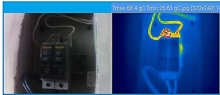
Figura 17-3: Prueba en instalación eléctrica Realizado por: Maldonado, L. 2018
