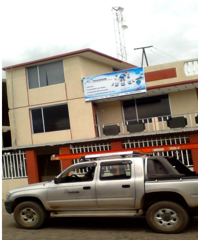
Oficinas de Telecom
