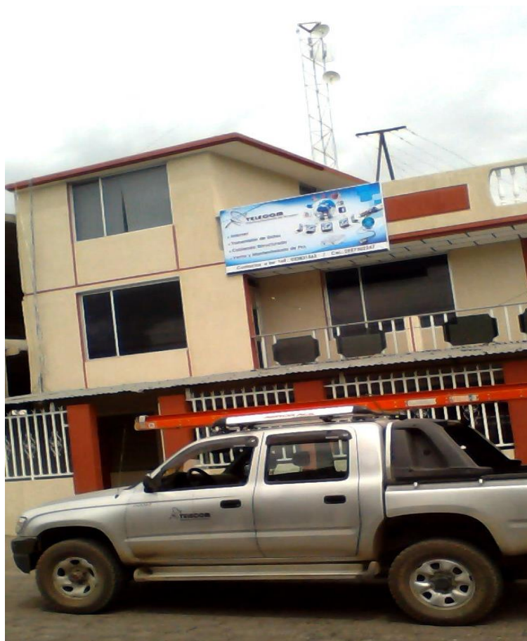
Figura 1: Oficinas de TELECOM.
