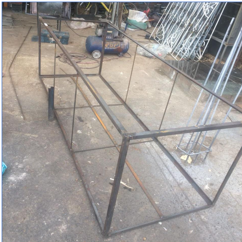
Estructura de la cámara anecoica.
