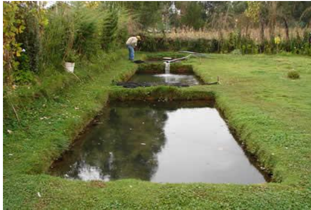
Figura18. Construcción del estanque.
