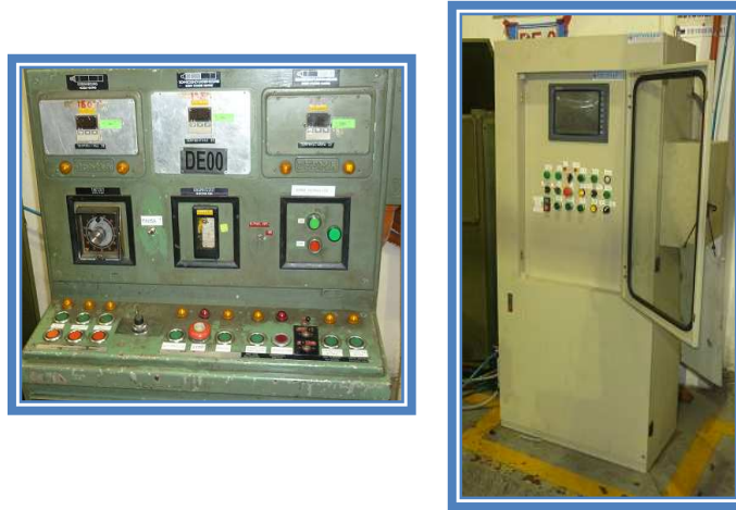
Figura 4.16. Tablero de control antiguo y actual respectivamente.
