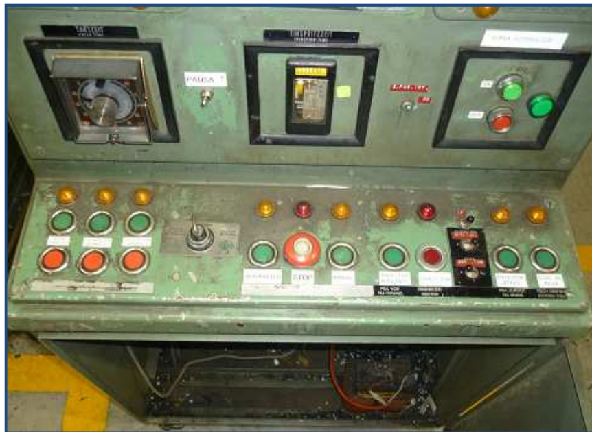
Figura 4.37. Tablero de control antiguo.
