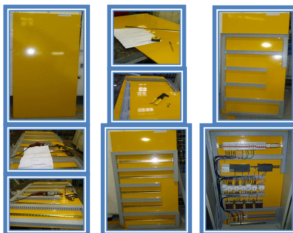
Figura 4.7. Proceso de colocación de las canaletas y el riel DIN estándar.
