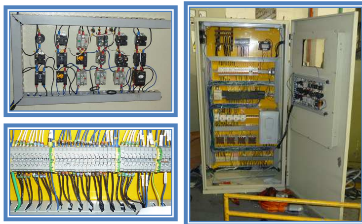
Figura 4.10. Cableado desde las borneras hacia el panel de control.
