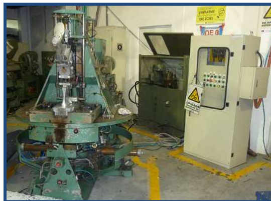
Figura 4.17. Tablero de mando instalado.
