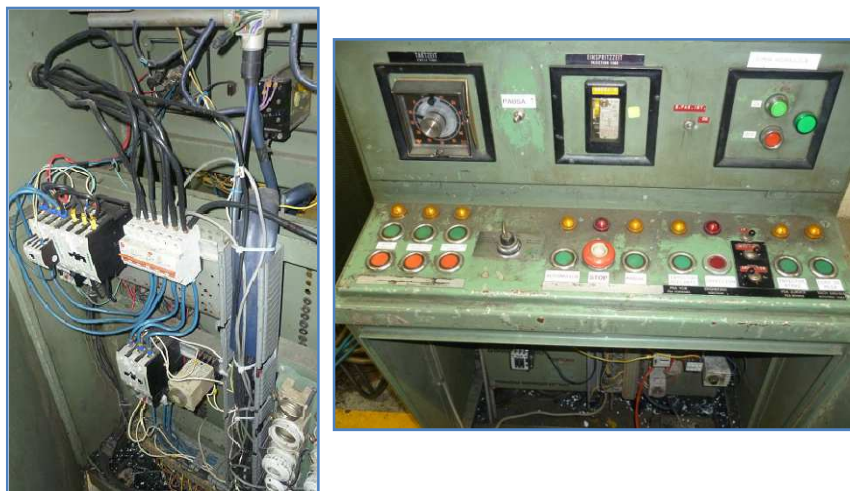
Figura 3.11. Tablero de control DE00.
