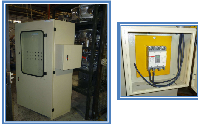
Figura 4.5. Tablero de control y fuerza.
