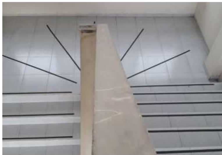
Figura 15-5: Graderío después de colocación de cinta antideslizante Realizado por: Darwin Dávila.
