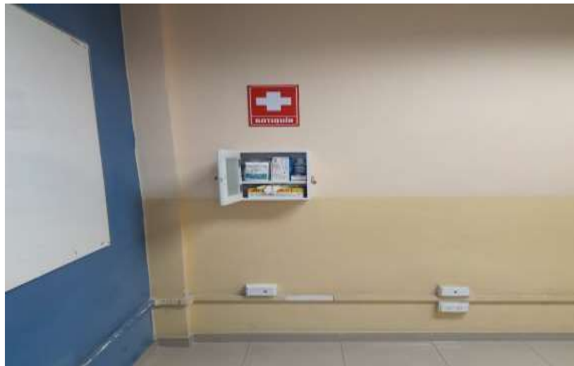
Figura 11-5: Botiquín después de dotación de elementos de primeros auxilios
