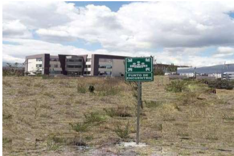
Figura 12-5: Punto de encuentro cimentado junto al Modular 2 de la E.I.MKT
