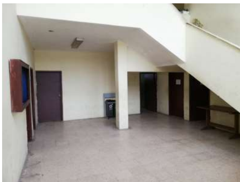
Figura 6-3: Pasillo principal/Planta baja/Edif.I.F
