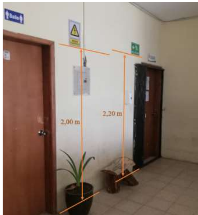
Figura 4-5: Señalización adv. evacuación/Pasillo principal/PA/Edif.I.F.
