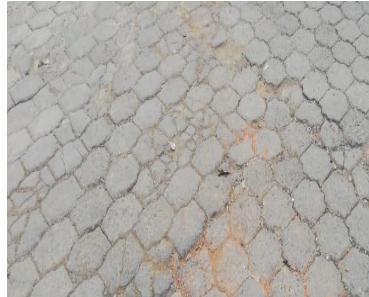
Foto 8 Fracturamiento
