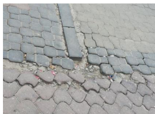
Foto 11 Escalonamiento entre adoquines
