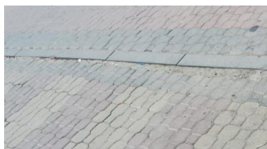
Foto 12 Escalonamiento entre adoquines y confinamientos
