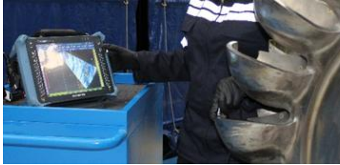
Figura 2-52: Inspección de rodete Pelton con ultrasonido PA.
