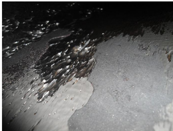
Figura 2-47: Reparación de álabes mediante cerámicos.
