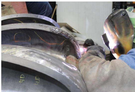
Figura 2-31: Reparación de Rodete Pelton por relleno con soldadura.
