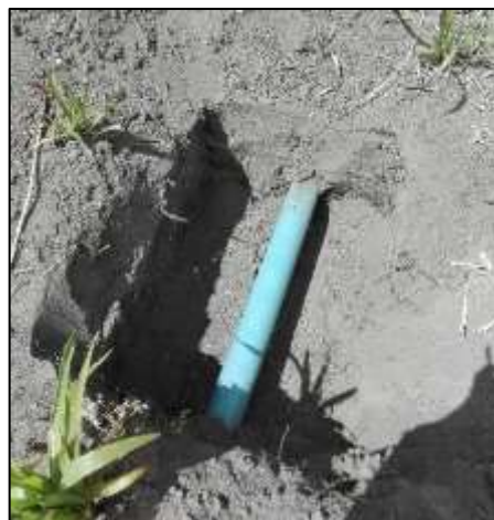
Figura 11-3: Excavación para medidas de caudal. Realizado por: Fiallos Avila Karen Lizbeth, 2019.
