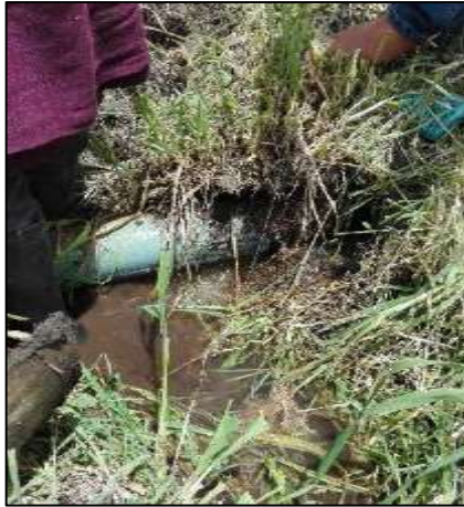
Figura 14-3: Fuga de agua usada para el regadío. Realizado por: Fiallos Avila Karen Lizbeth, 2019.
