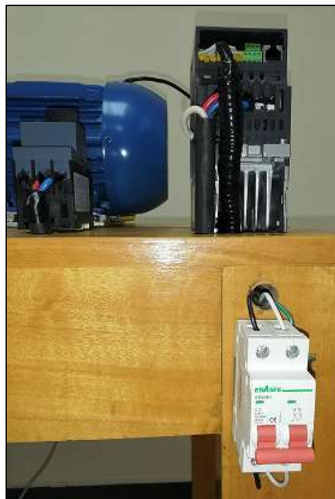
Figura 9-3: Instalación de breaker bipolar.
