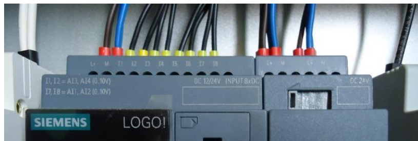
Figura 13-3 Conexión de entradas del relé programable
