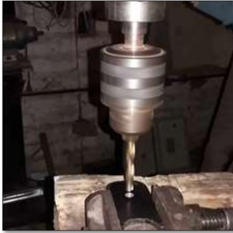
Figura 68-3: Taladrado de anclajes
