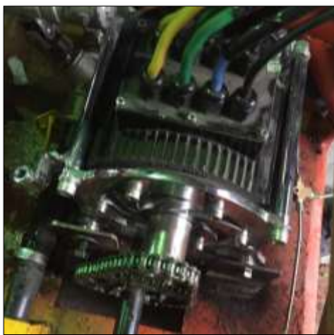
Figura 55-3: Instalación del motor en sus bases
