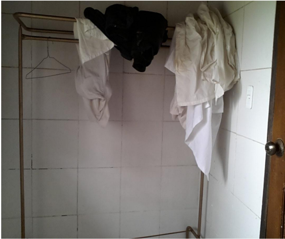
Figura 17-11: Vestidores del personal, dentro de la batería sanitaria Realizado por: Miguel Romero. 2018
