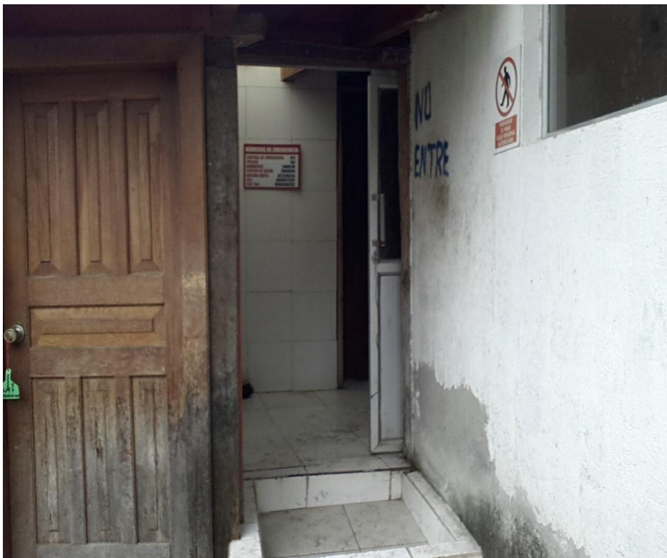
Figura 14-11: Ingreso del personal a la planta Realizado por: Miguel Romero. 2018
