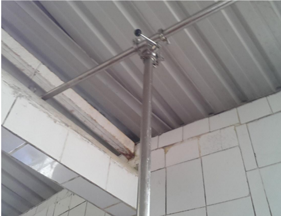
Figura 27-11: Área de procesamiento, transformación de la leche en queso Realizado por: Miguel Romero. 2018
