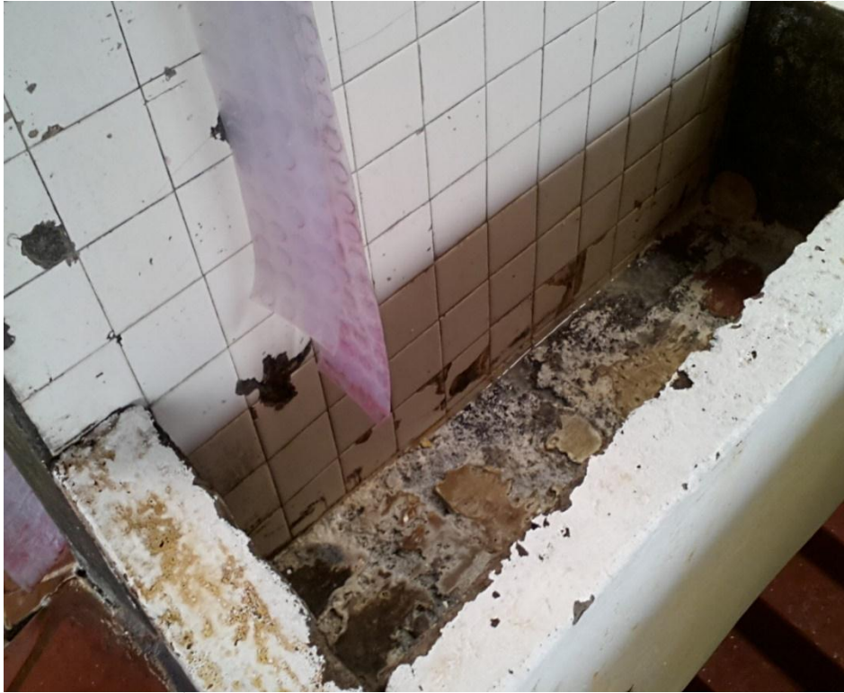
Figura 35-11: Área de procesamiento, transformación de la leche en queso Realizado por: Miguel Romero. 2018
