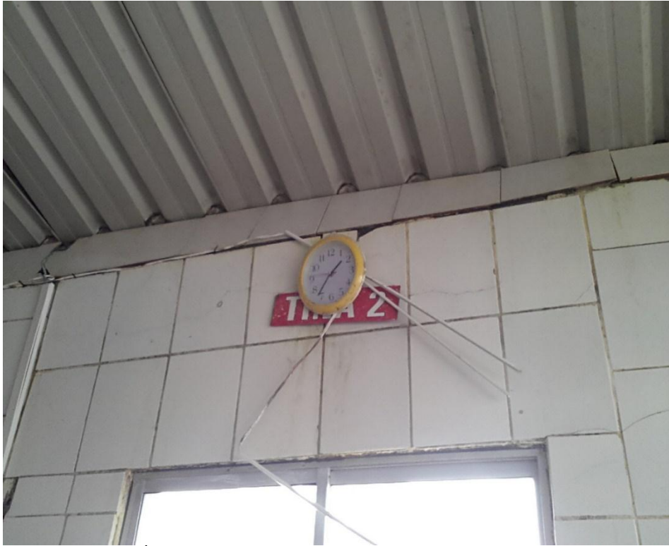
Figura 23-11: Área de procesamiento, transformación de la leche en queso Realizado por: Miguel Romero. 2018
