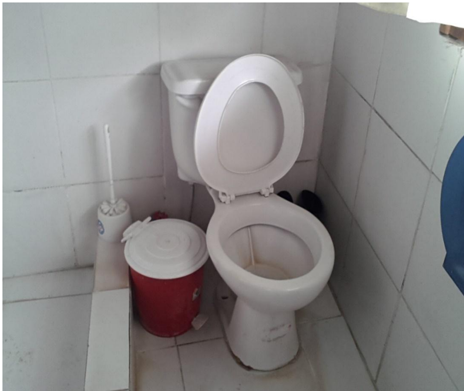
Figura 18-11: Batería sanitaria del personal Realizado por: Miguel Romero. 2018
