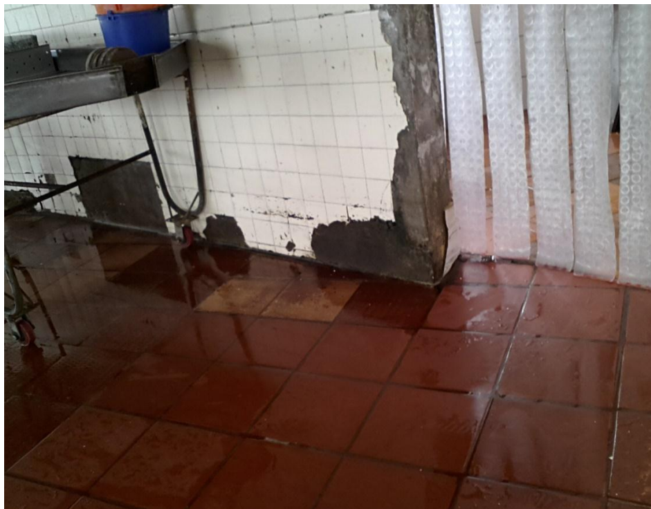
Figura 32-11: Área de procesamiento, transformación de la leche en queso Realizado por: Miguel Romero. 2018
