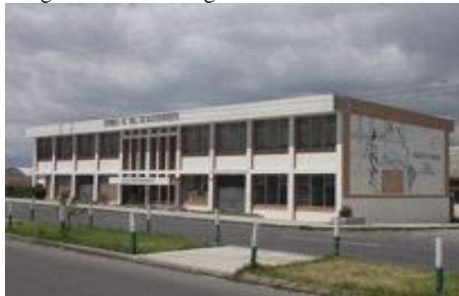
Figura 5. Escuela Ingeniería de Mantenimiento
