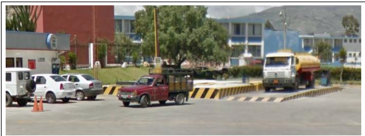
Almacenamiento de combustible
