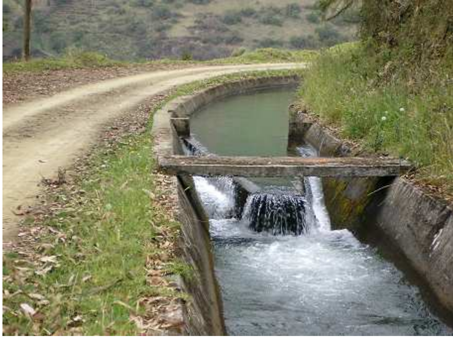
Fig. 6: Desarenador canal de riego río Blanco
