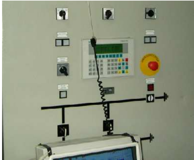
GRAFICO 1.- Simatic S5 tablero de control y procesador para la medición los caudales río Blanco.
