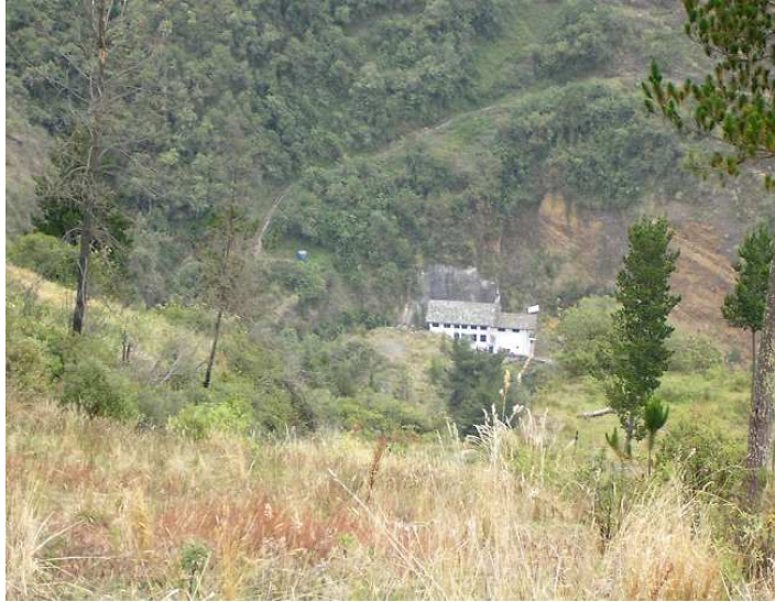
GRAFICO 2.- Vegetación de los alrededores de la central hidroeléctrica de río Blanco.
