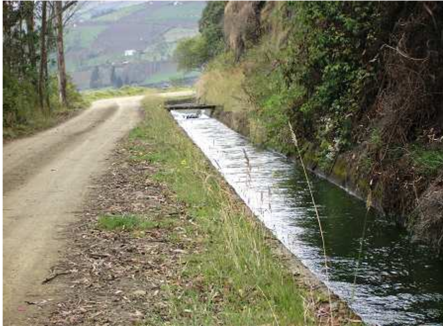
Fig. 7: Vista general canal riego río Blanco
