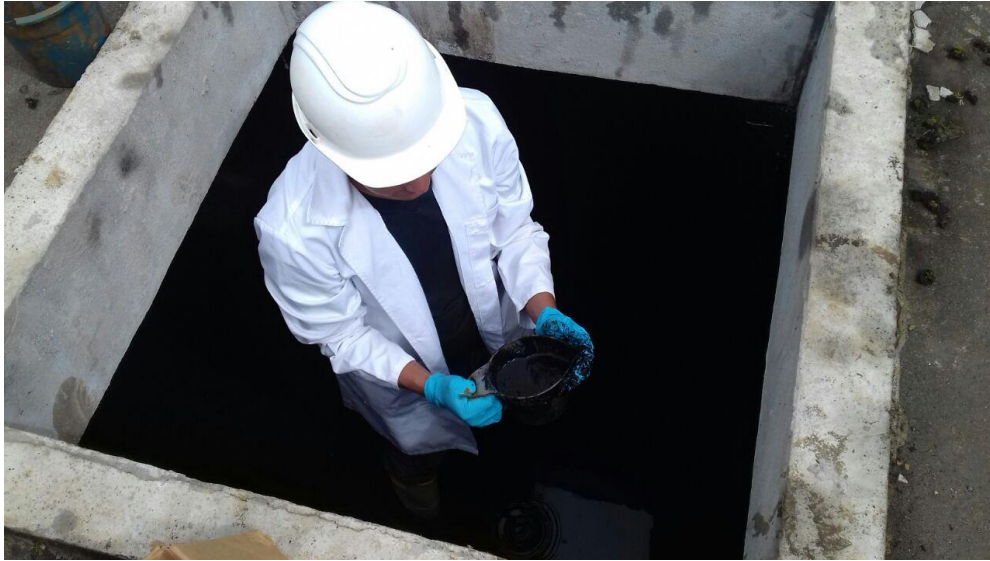
Figura 6-3: Mantenimiento del filtro anaerobio y obtención de la muestra de lodos.
