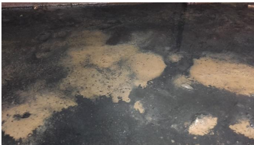
Figura 5-3: Mantenimiento del tanque séptico
