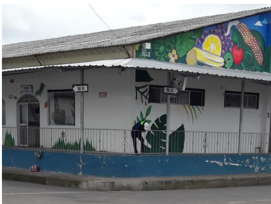
Fotografía 4-6 Centro comercial, con señalización. Realizado por: Pilamunga E. 2019.
