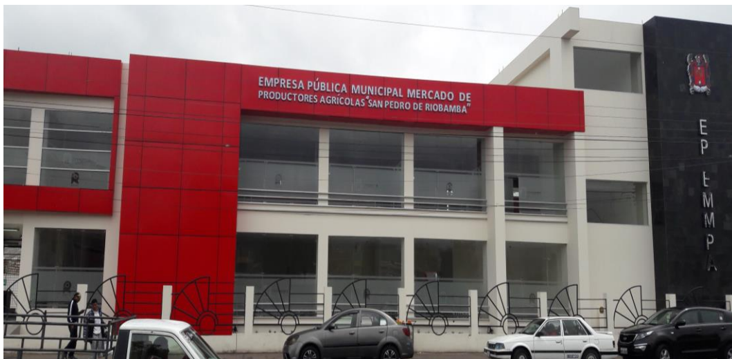
Fotografía 4-1 Nuevo edificio de la EP-EMMPA. Realizado por: Pilamunga E. 2019.
