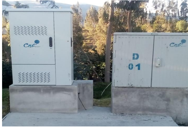
Figura 3-6 Equipo de Plataforma Ext. y Armario Reflejo. Fuente: Alba Verónica Ramos Flores, 2019.
