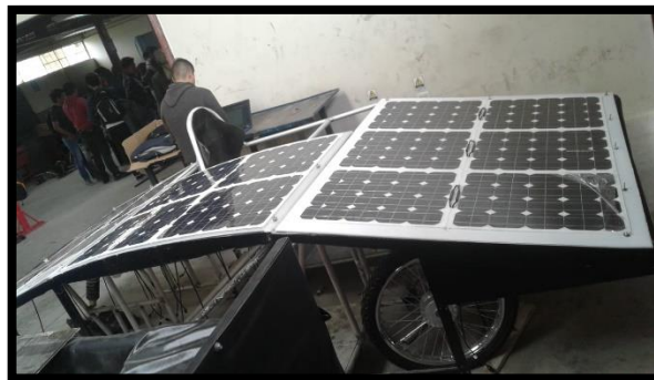
Figura 12-3: Montaje paneles solares.
