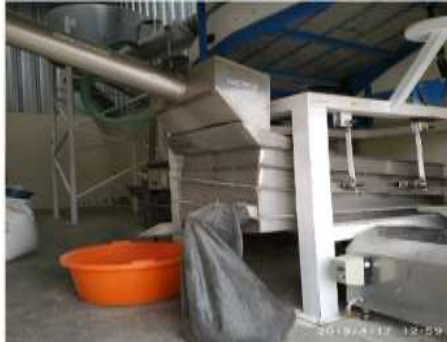
Figura 4-3. Escarificado y despedregado Fuente: Autores
