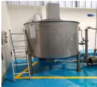
Figura 5-3. Lavado Fuente: Autores
