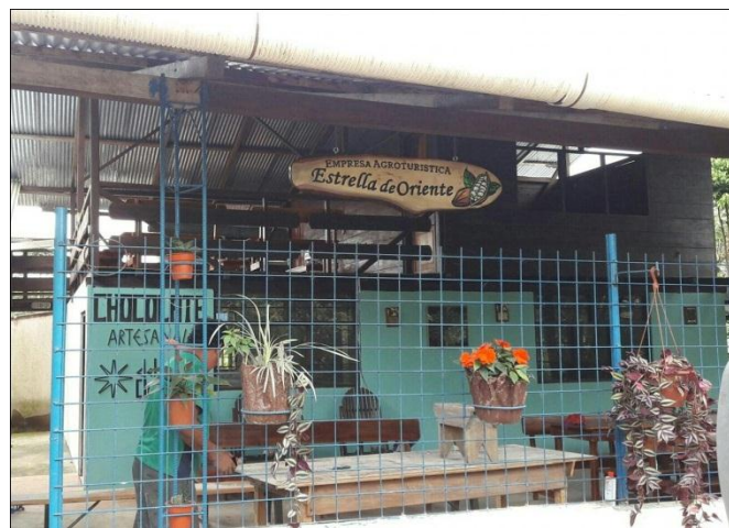
Anexo C: Instalaciones
