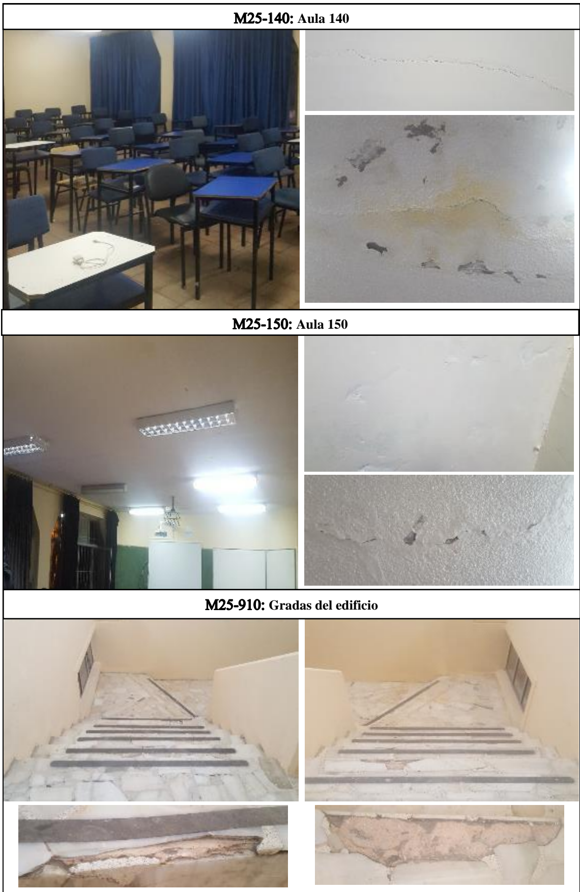
Figura 10-3: Aula 140, 150 y Gradas del edificio
