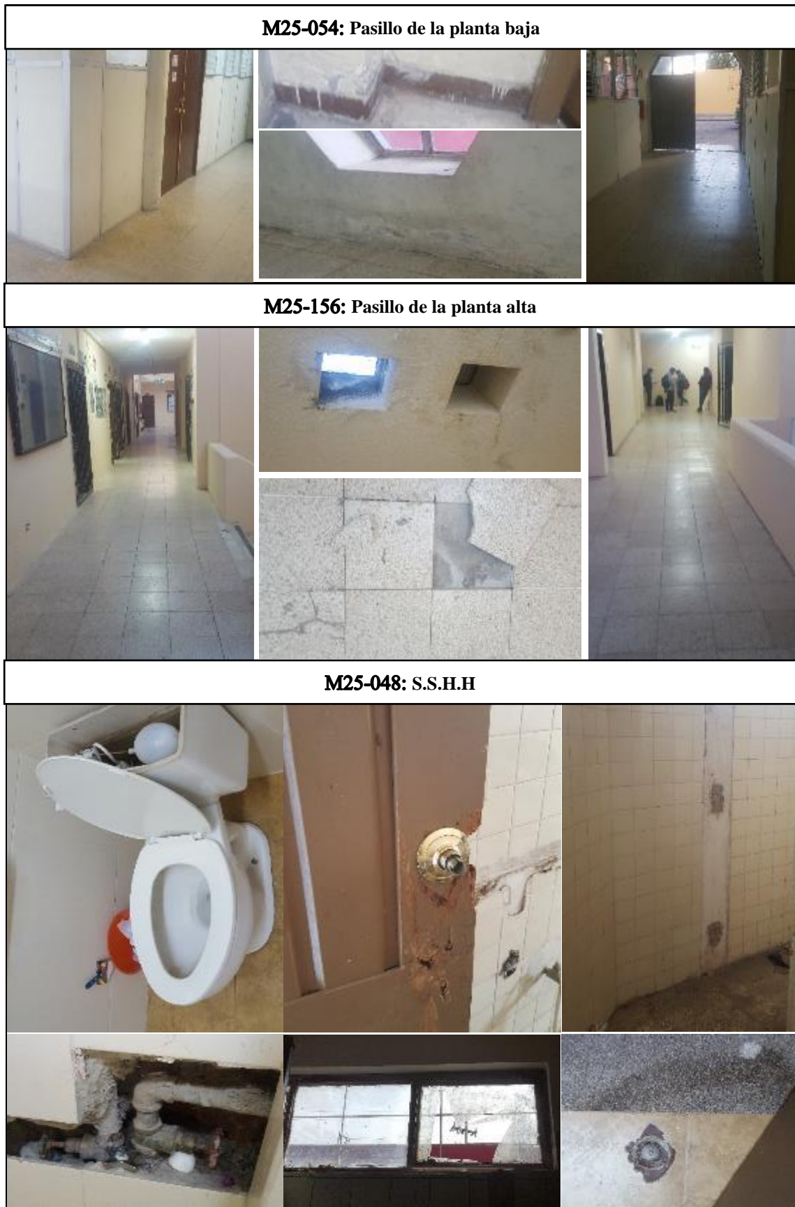
Figura 11-3: Pasillo de la planta baja, Pasillo de la planta alta y S.S.H.H
