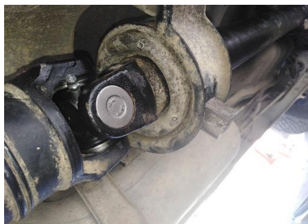
Figura 7-4.: Junta de la pesa cubica en el puente de anclaje medio del cardan
