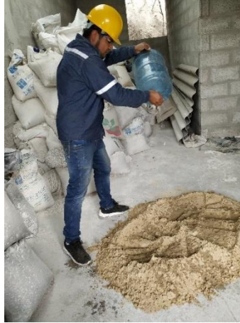
Figura 37-3: Preparación de la arena
