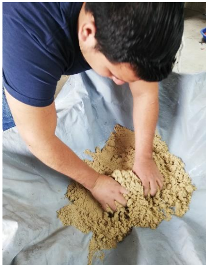
Figura 40-3: Mezcla del aglutinante.
