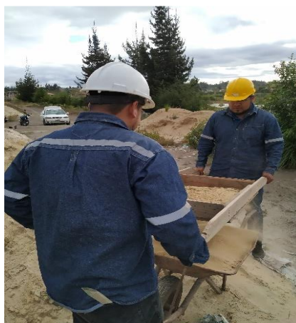
Figura 36-3: Selección de la arena mediante tamiz.
