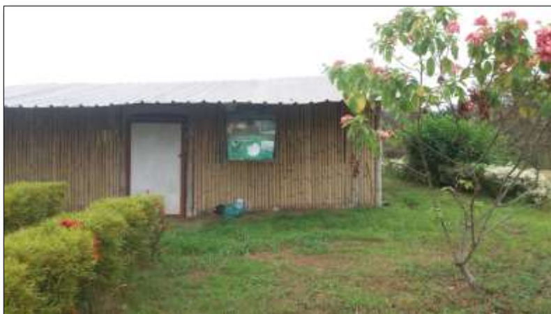
Figura 2-1: Vista exterior del Galpón en la UTEQ
