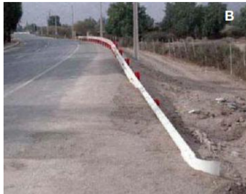
Ilustración 18-2: Terminal en Abatimiento
