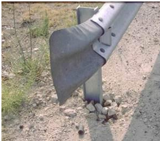
Ilustración 17-2: Terminales en cola de pescado
