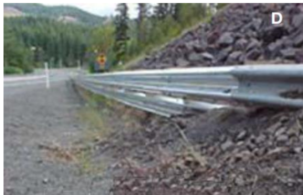
Ilustración 19-2: Terminal empotrado en un talud
