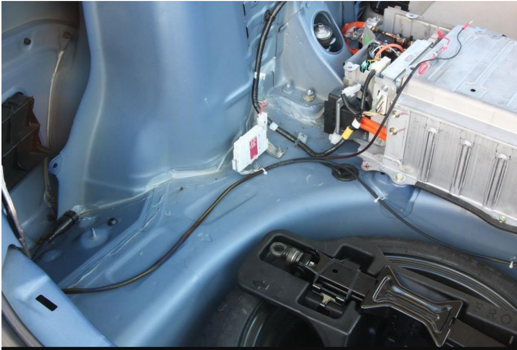
Figura 37-3. Cargador de baterías conectado en un auto de pruebas
