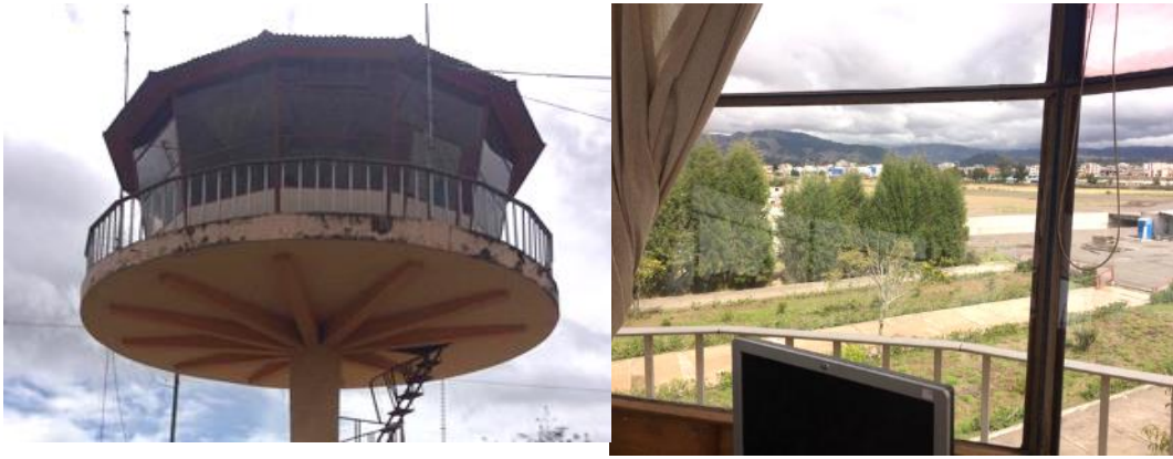
Figura 15-4: Torre de control actual Fuente: Propia
