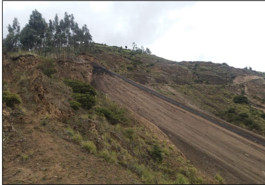
Figura 6-4: Vista margen lateral derecha Escombrera Puninhuaico Fuente: Yadira Balseca Rosero
