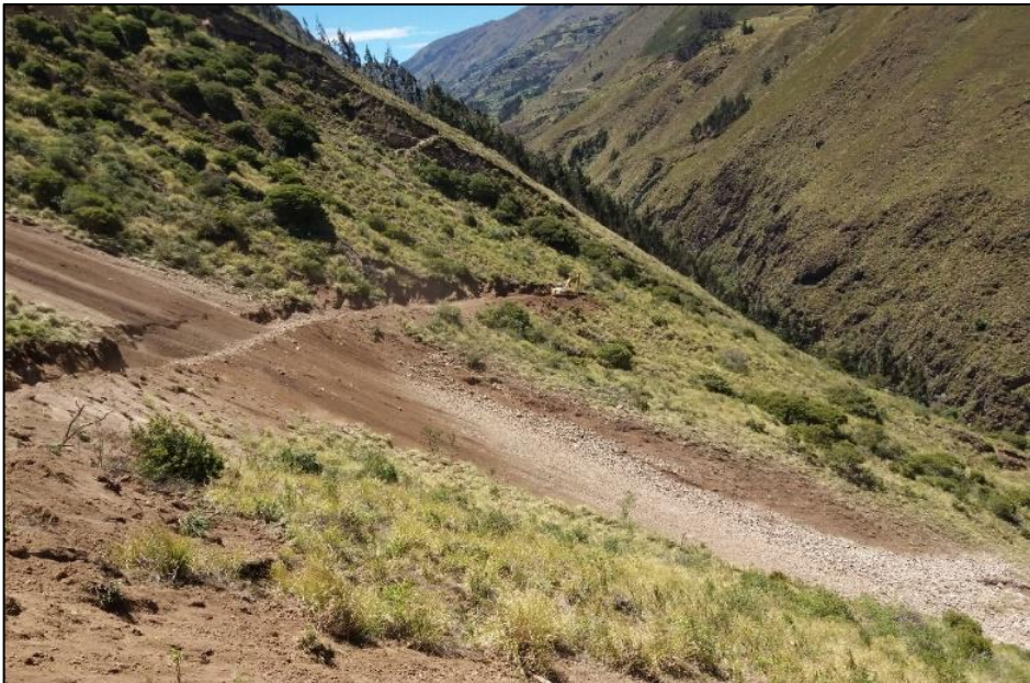
Figura 3-4: Apertura de la Vía de acceso para conformación de plataforma
