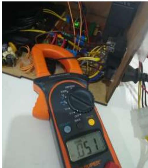
Figura 5-3: Medición de corriente en la Fuente AC Realizado por: Coyago, Jhinson & Coyago, Jonathan. 2019
