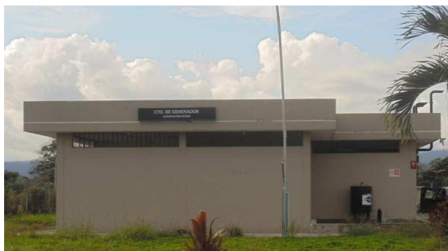
Figura 8-3: Cuarto de generadores auxiliares de energía Realizado por: Ocampo Martínez, Gregory, 2019
