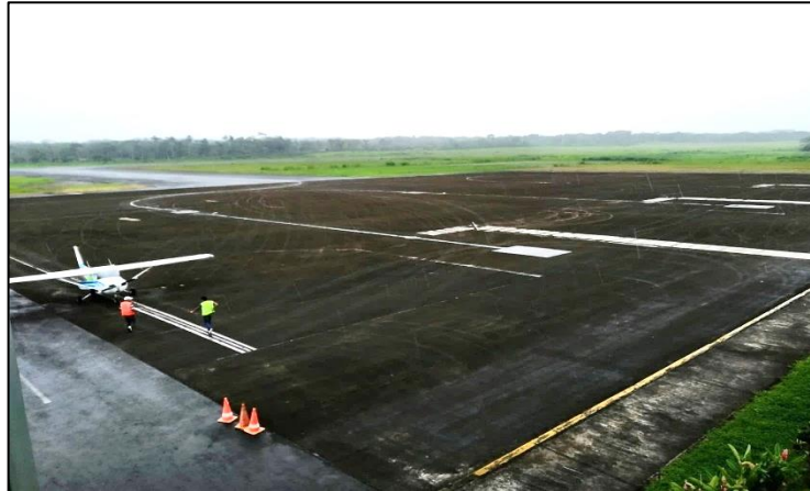
Figura 4-3: Plataforma aeropuerto Jumandy
