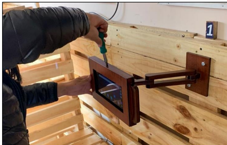
Figura 8-3: Instalación del soporte del módulo de gestión
