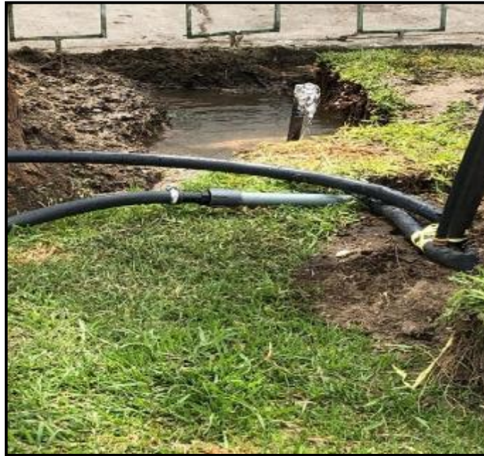
Fotografía 10-4. Toma de abastecimiento para el acople del juego de seguridad con llave de paso
