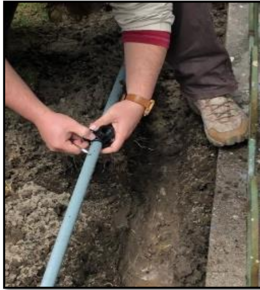
Fotografía 8-4. Acople de collarín a la red principal de nuestro sistema de riego
