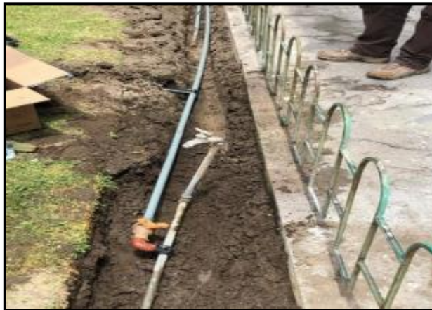
Fotografía 7-4. Tubo de red principal del sistema de riego de la primera parcela
