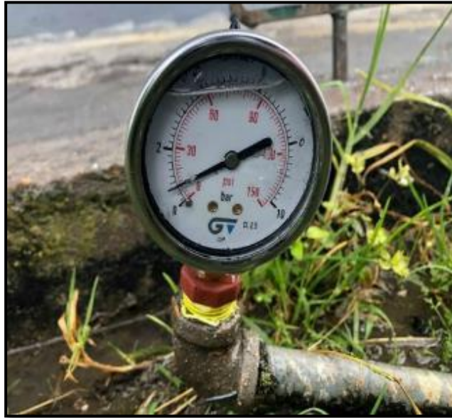
Fotografía 5-4. Manómetro de Glicerina en marcación de presión en bares a las dos tomas principales de abastecimiento
