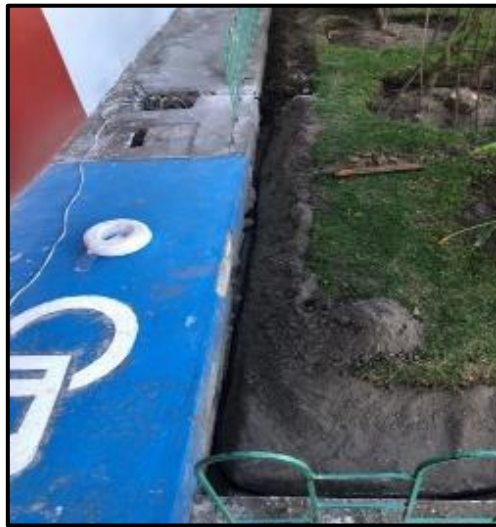
Fotografía 12-4. Zanjeo para las líneas de alimentación eléctrica
