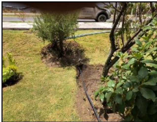
Fotografía 9-4. Ramal Secundario con micro aspersor MINI-WOBBLER
