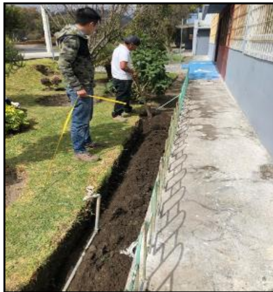
Fotografía 2-4. Suelo Franco Arenoso y Profundidad de Zanjeo
