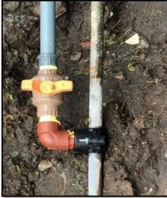
Fotografía 6-4. Conexión de la llave universal con llave, a la primera toma de abastecimiento para el sistema de riego
