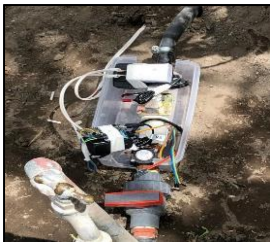
Fotografía 13-4. Sistema de control automatizado
