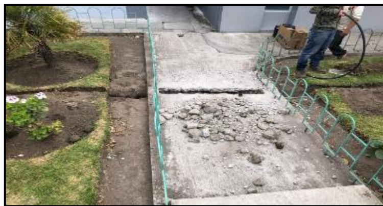
Fotografía 4-4. Ramal secundario debajo de concreto
