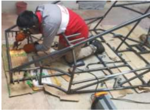
Figura 48-3. Soldadura de piezas.
