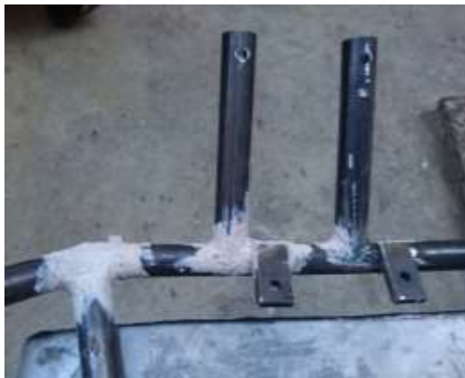
Figura 49-3. Masillado de soldaduras.
