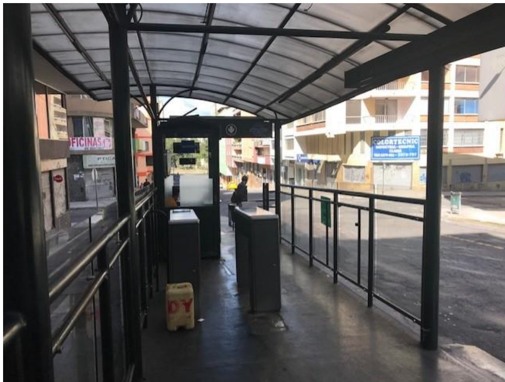
Figura 12 – 4: Parada Santa Prisca, Corredor Sur Occidental, ilustración parada sin servicio de guardianía Realizado por: Verónica Cahuasquí
