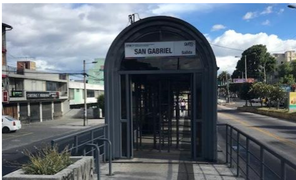
Figura 10 – 4: Parada San Gabriel, Corredor Sur Occidental, ilustración parada con cámara de seguridad.
