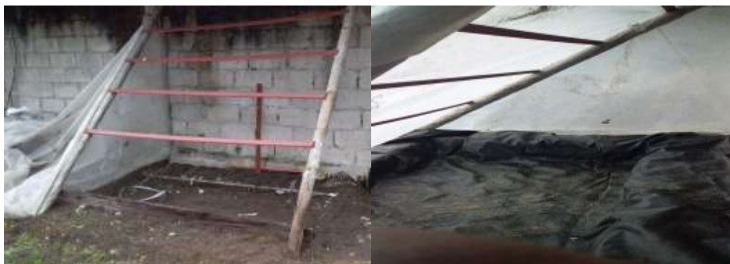
Figura 2-2. Construcción del invernadero.
