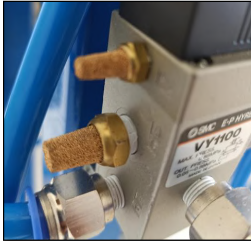
Figura 7-4. Instalación de silenciadores a la válvula neumática
