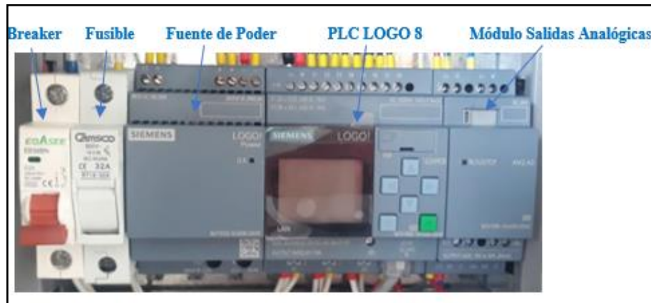
Figura 11-4. Instalación y conexión del sistema de control automático.
