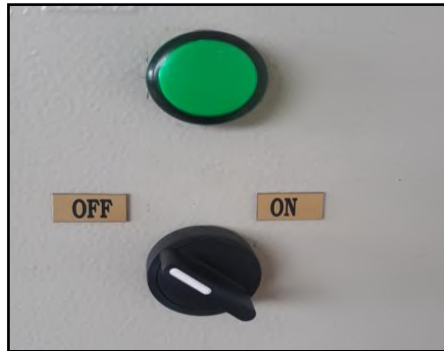
Figura 13-4. Instalación de selector y luz piloto
