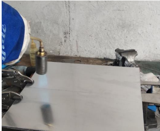
Figura 15-3: Pre calentamiento de las juntas para soldar
